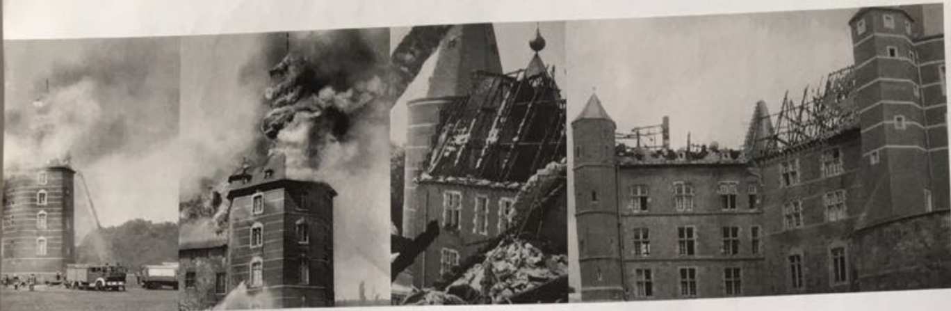
Het dak dat uiteindelijk verloren ging
