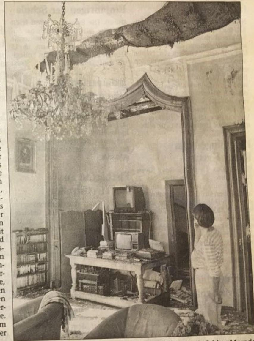
Einsturzgefahr: Bis in die Parterre sind die Lehmdecken in Schloss Merode aufgeweicht. An manchen Stellen sind sie schon durchgebrochen oder der Putz ist großflächig abgesprungen.
